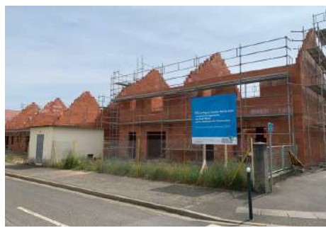
Projet Kalan Immobilier - rue Jean Macé
